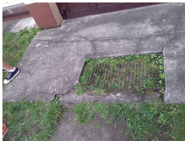
demontaż stalowej zagłębionej wycieraczki i skucie betonowego podestu ( stopnia) przed wejściem
