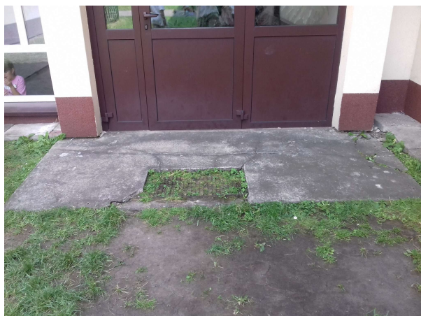
demontaż stalowej zagłębionej wycieraczki i skucie betonowego podestu ( stopnia) przed wejściem
